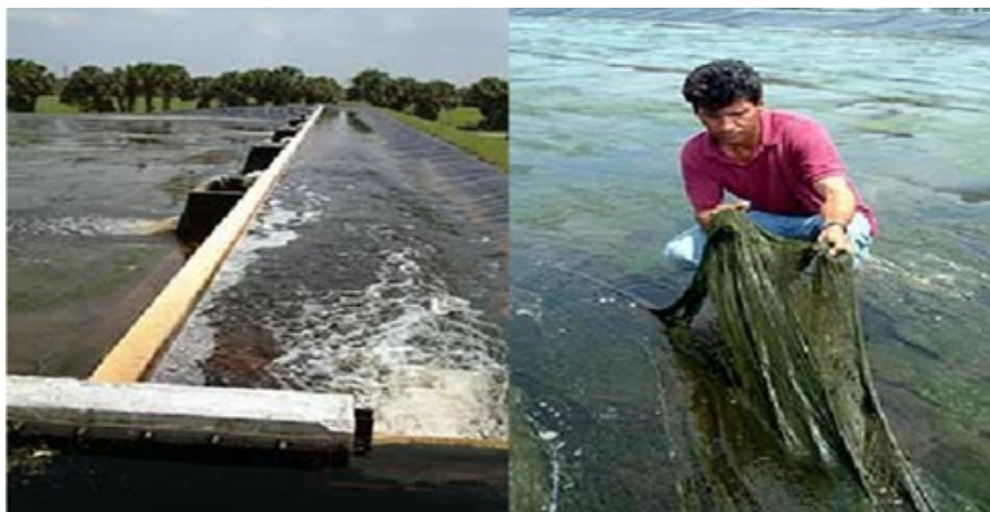
Figure 2. The biggest ATS sewage treatment system in California (from the United States, Hydromentia Corporation) 图 2. 美国加利福尼亚最大的 ATS 污水处理系统(摘自美国, Hydromentia 公司)
