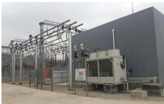
Figure 7. DC ice melting device 图7. 直流融冰装置
