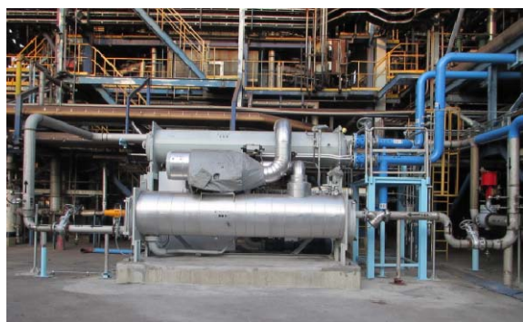
Figure 7. ORC generating system sited at a petrochemical factory 图 7. 石油化学工厂的有机朗肯循环发电系统全图, ORC 机台置于水泥基座上
